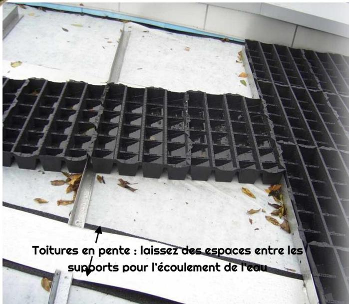
Toitures en pente : laissez des espaces entre les supports pour l'écoulement de l'eau
